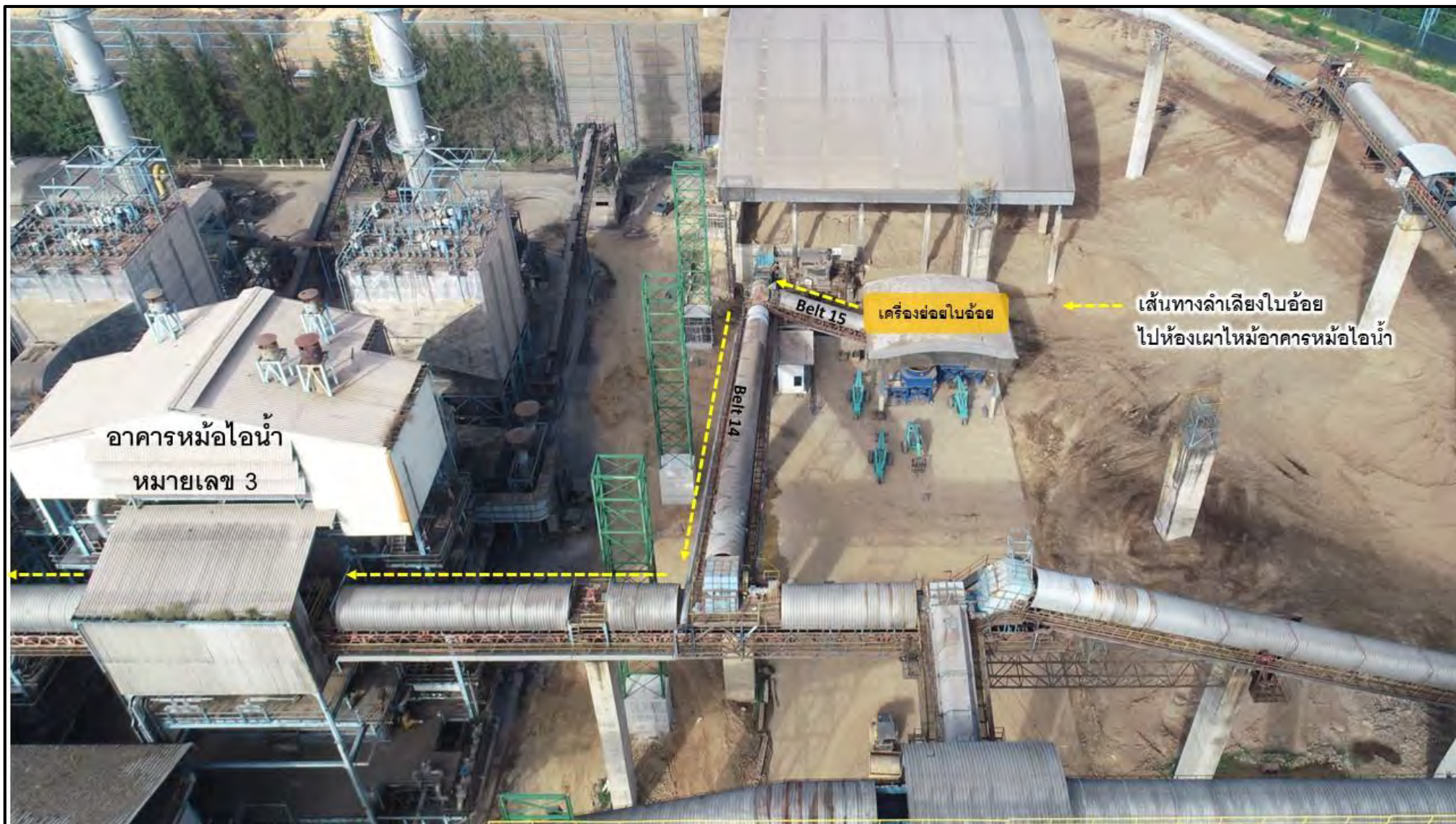
รูปที่ 2.3-4 เส้นทางลำเลียงใบอ้อยจากเครื่องย่อยใบอ้อยไปห้องเผาไหม้อาคารหม้อไอน้ำ
